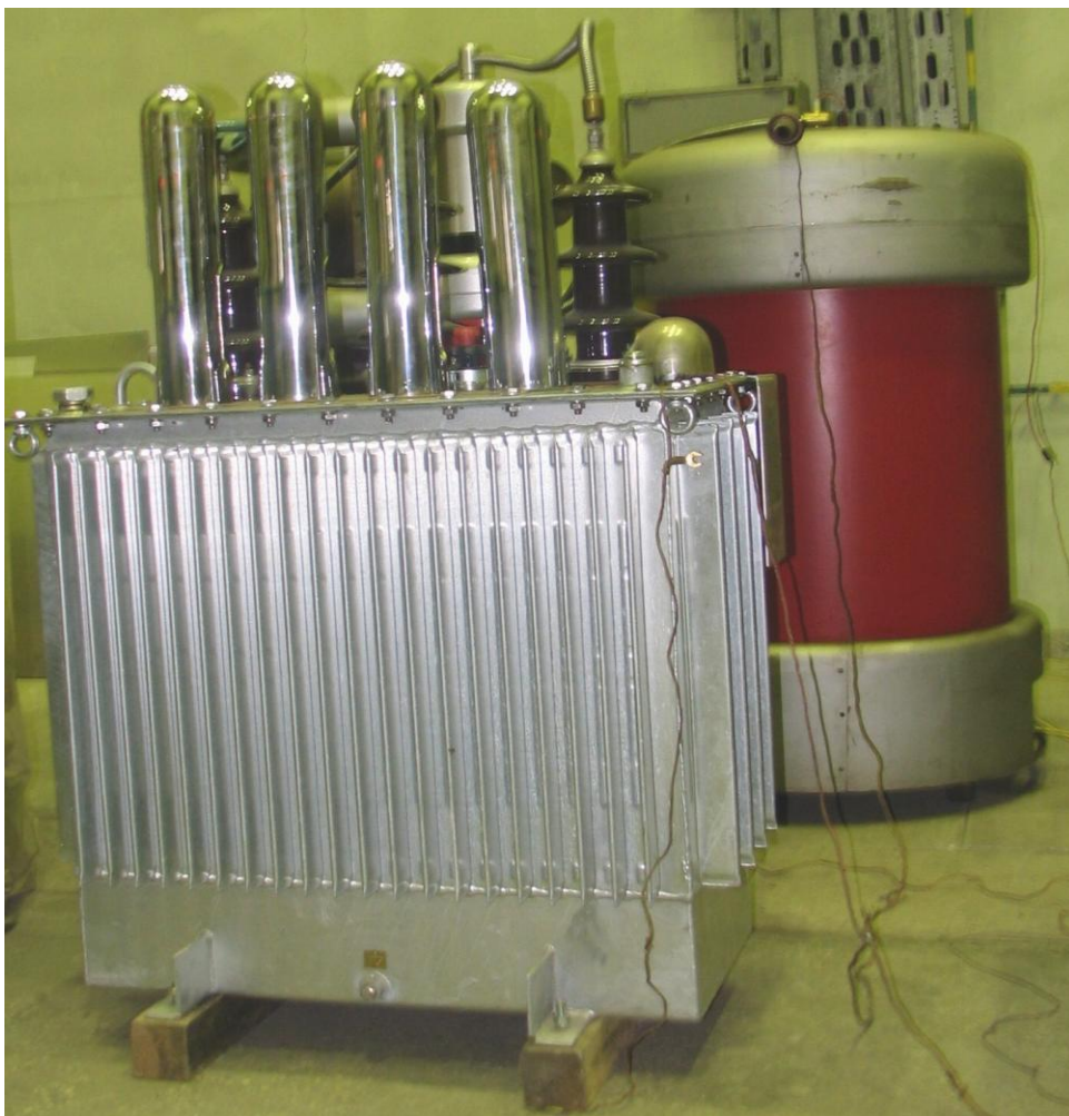
Transformator rozdzielczy podczas badania wyładowań niezupełnych
